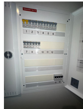
Sikringsskap med automatsikringer.
