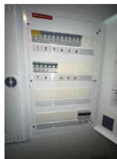
Sikringskap med automatsikringer.
