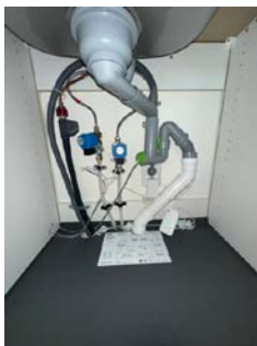
Røropplegg i kjøkkenbenk med Waterguard
