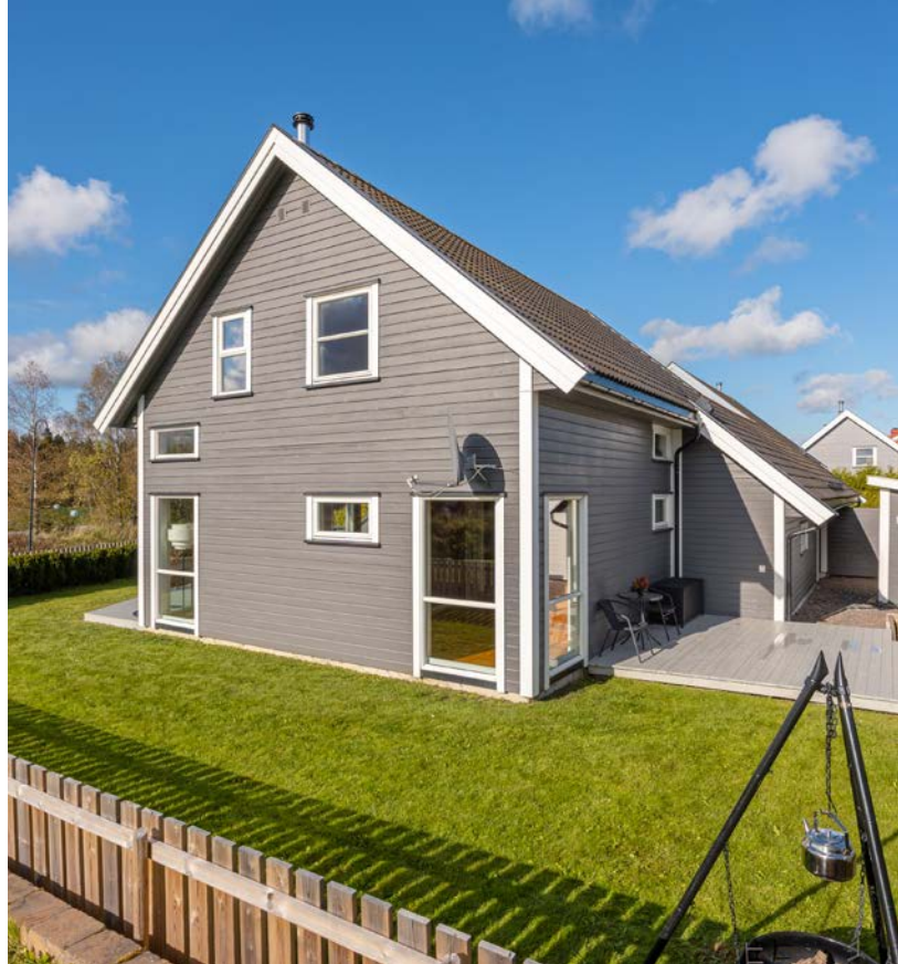
Boligen har terrasser på begge sider av boligen - så her kan du følge solen gjennom dagen.
