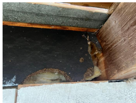
Utettheter og åpen veggkonstruksjon under terrasse
