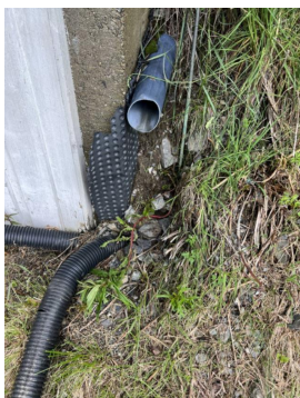
Manglende bortledning av takvann, forårsaker idag fuktpåvirkning mot yttermur/bygningskropp
