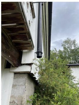
Manglende bortledning av takvann, forårsaker idag fuktpåvirkning mot yttermur/bygningskropp
