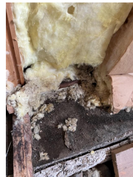
Ved fuktmåletaking av trevirke mot gulv på grunn og mot yttermurer er det fukt og påbegynnende muggsopp
