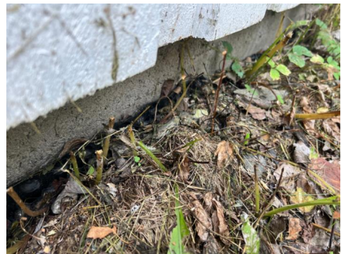
Synlig knotteplast mot mur, stedvis avsluttet under terreng
