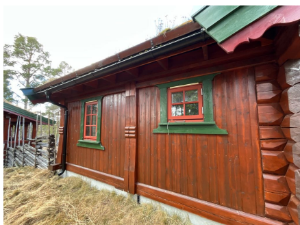
Bygningsdel med stavlaft
