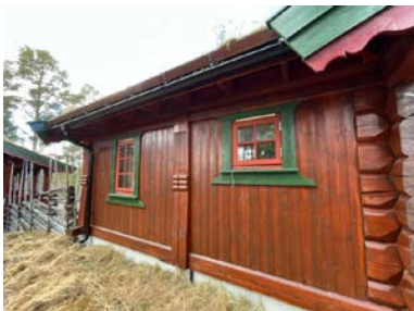
Bygningsdel med stavlaft
