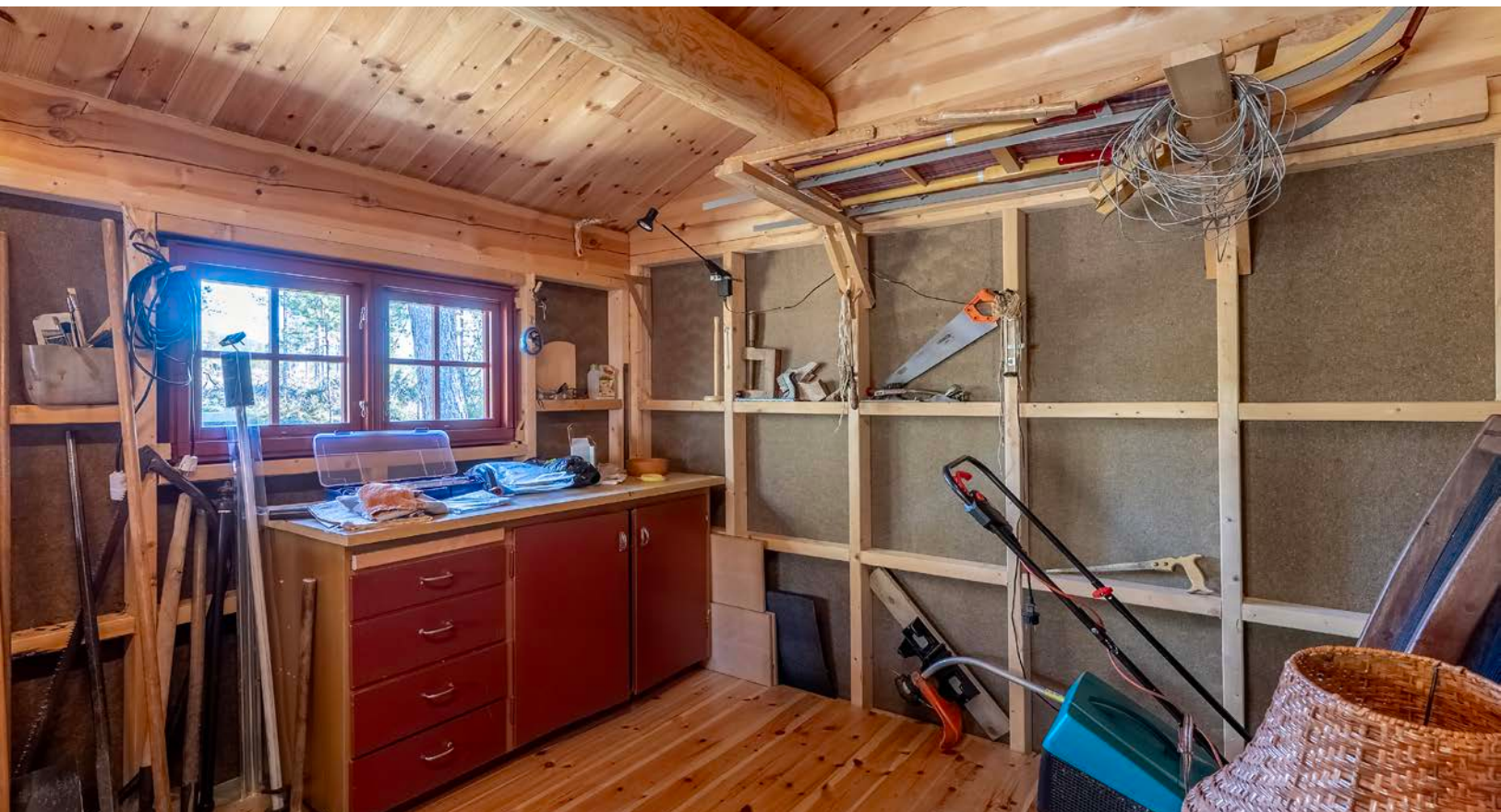
Uthuset er ca. 15 m 2 og har innlagt strøm samt isolert gulv og tak
