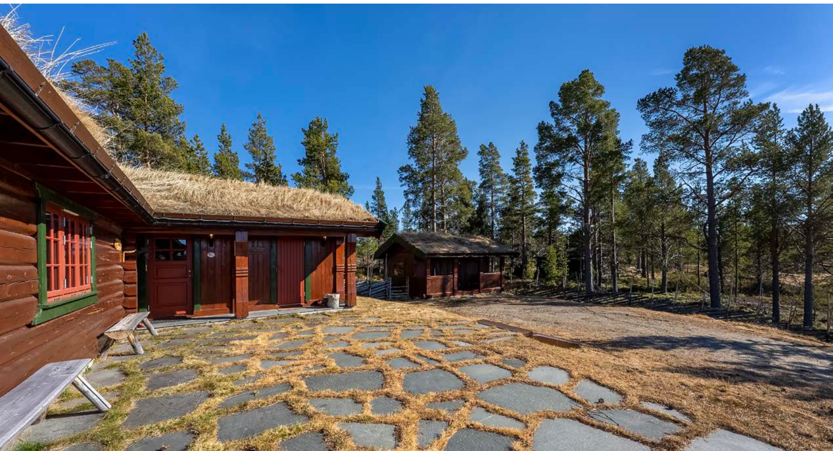
Foran hytta er det opparbeidet plen/gressbakke og markterasse med steinheller - Innkjørsel og gårdsplass er gruset
