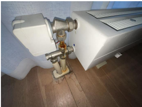
Drypplekkasje gulvradiator.
