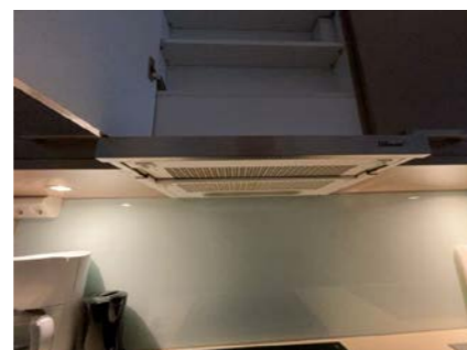
Avtrekk kjøkkenet.
