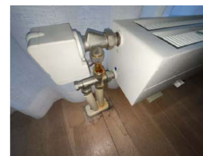
Drypplekkasje gulvradiator.
