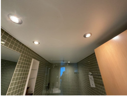
Utsnitt vegger og himling.
