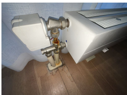
Drypplekkasje gulvradiator.
