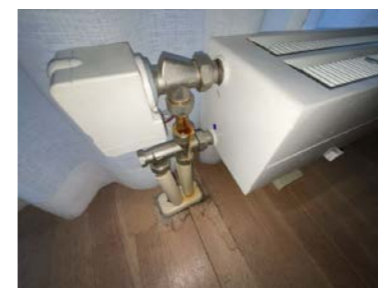
Drypplekkasje gulvradiator.
