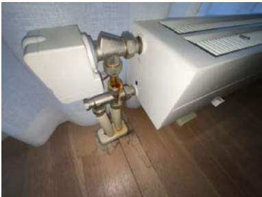
Drypplekkasje gulvradiator.
