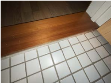
Riss og sprekk i fug mellom dørstokk og gulv.
