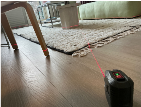
Nivellering stue, avvik ca. 10-20 mm
