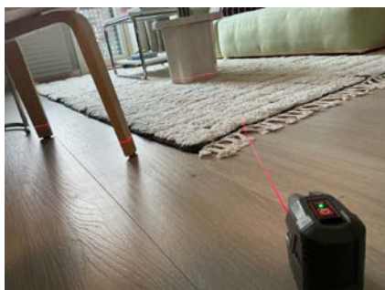
Nivellering stue, avvik ca. 10-20 mm
