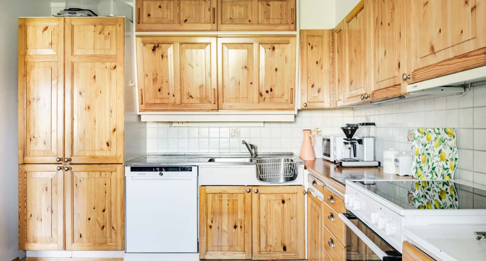
Kjøkkeninnredningen har profilerte heltre fronter, laminerte benkeplater, benkebeslag med nedfelt oppvaskkum og fliser i benkeryggen. Fronter fremstår som nyere enn skrogene.
