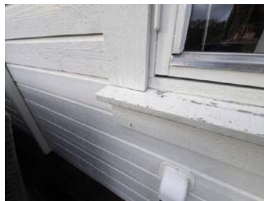
Ikke montert beslag og luftespalte
