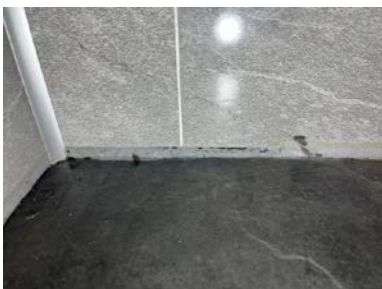
Sprekk i fuge mellom gulv og vegg bak badekar
