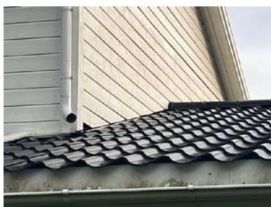
Kort avstand fra kledning til tak
