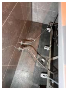
Sprekk i fuge mellom gulv og vegg bak badekar
