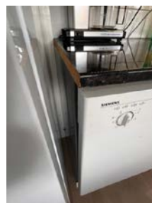
Mangler finer på ende av benkeplate
