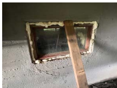
Ikke montert beslag og luftespalte
