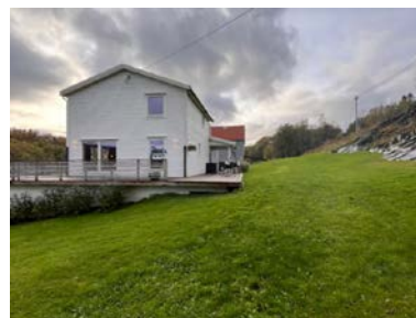
Terreng skrår ned mot grunnmur
