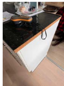
Mangler finer på ende av benkeplate
