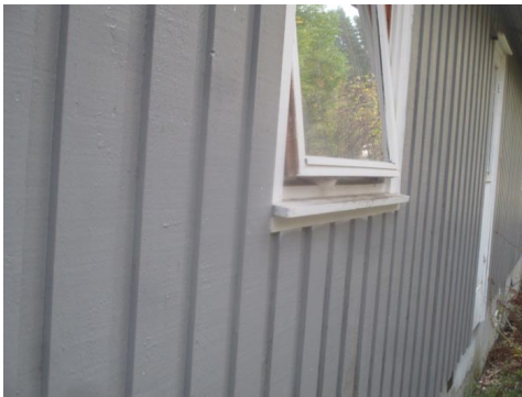
Deler av kledningen med tilhørende belistninger.
