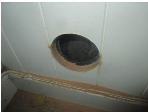
Hulltaking i utfored vegg på soverom i enhet 42.
