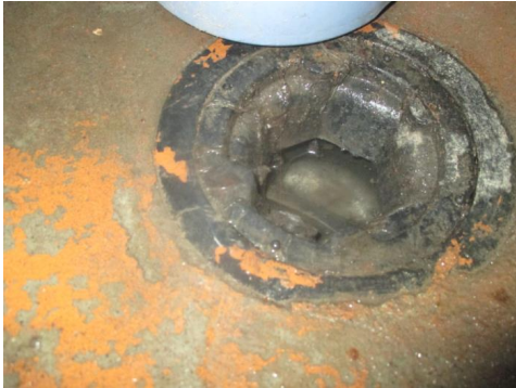
Eldre sluk i gulvet.
