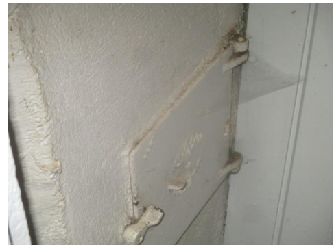
Sotluke i gangen under trapp i nummer 42.
