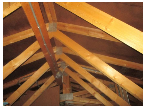
Deler av takkonstruksjonen (nr: 42)
