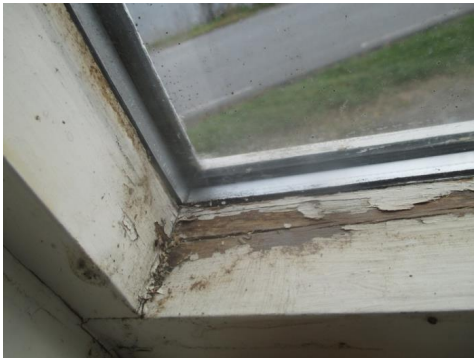
Kondensmerker/skader innvendig.
