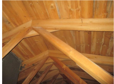
Deler av takkonstruksjonen (nr:40)
