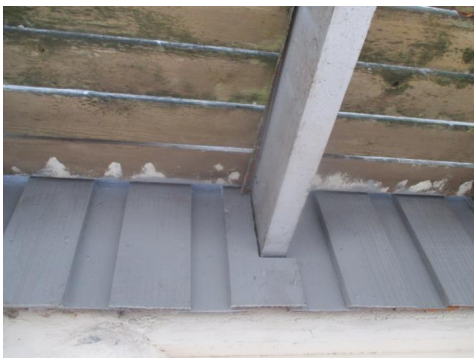
Bjelkelaget er ført inn i hovedbjelkelaget i boligen.
