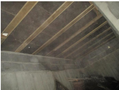
Deler av stubbloftet i mot krypkjeller i enhet 40.
