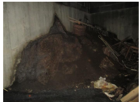
Deler av krypkjeller.
