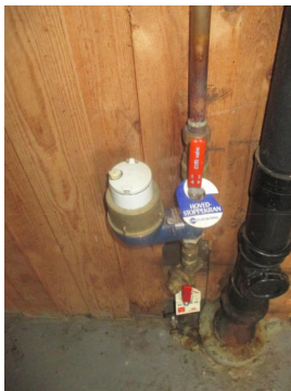
Innvendig stoppekran med vannmåler på hobbyrom i nr: 42
