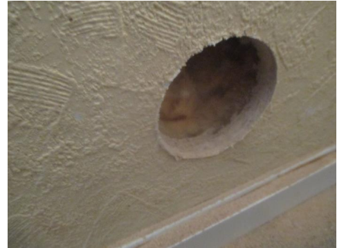
Hulltaking i fra soverom.
