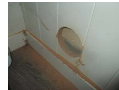
Hulltaking i fra soverommet.
