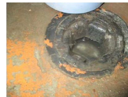
Eldre sluk i gulvet.
