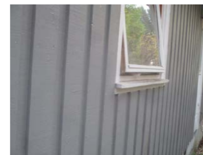
Deler av kledningen med tilhørende belistninger.
