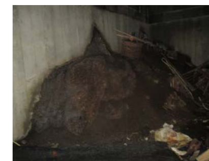
Deler av krypkjeller.
