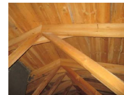
Deler av takkonstruksjonen (nr:40)
