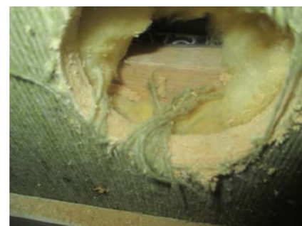
Hulltaking i fra soverommet.
