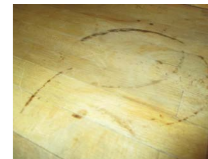
Slitasje/skader på benkeplate.
