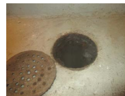
Eldre opprinnelig sluk.
