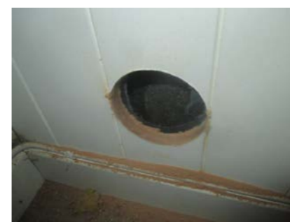
Hulltaking i utfored vegg på soverom i enhet 42.
