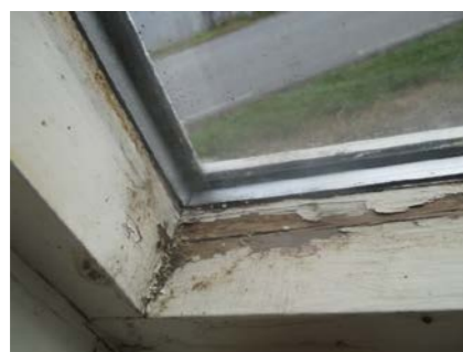
Kondensmerker/skader innvendig.
