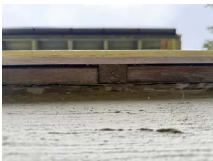
Det er liten luftespalte bak kledning.
