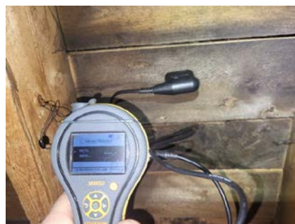
Ingen unormale fuktforhold påvist.
