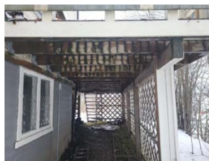
Fundamentering med trepilarer.
