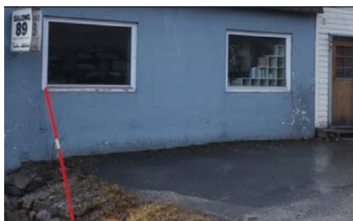
Grunnmur mot på tilbygg mot gate.
