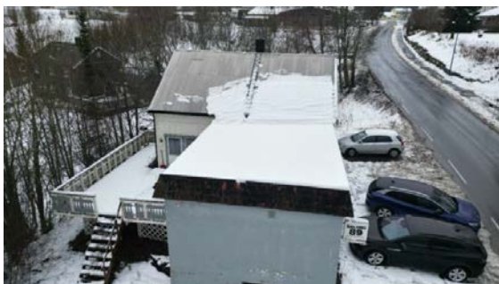
Snødekt tak på tilbygg.
