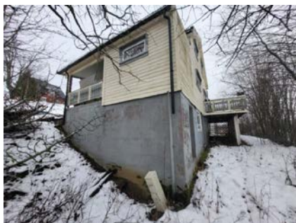
Grunnmur av betonghulstein og betong.
