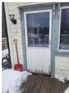
Terrassedør med råteskader i nedre kant.
