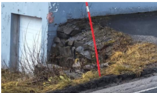
Forstøtningsmur med naturstein.
