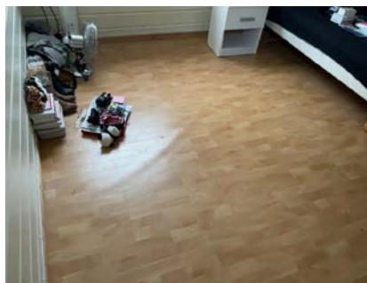
Gulv på et soverom i loftetasjen.
