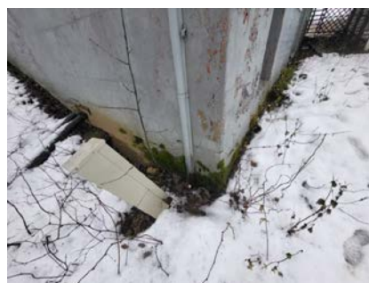
Grunnmur av betonghulstein på tilbygg.
