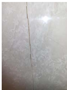
Sprekker i skjøter på veggplater.
