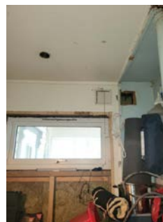
Uinnredet vegger på bod i hovedetasjen.
