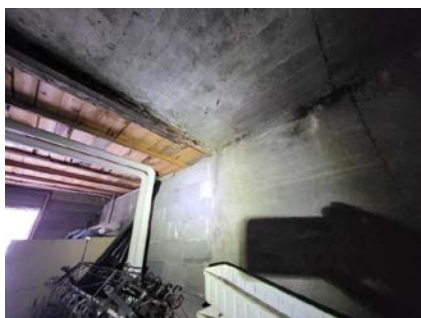
Innvendig grunnmur av betonghulstein og betong.
