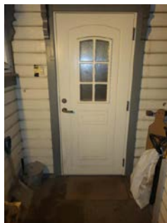
Terrassedør med råteskader i nedre kant.
