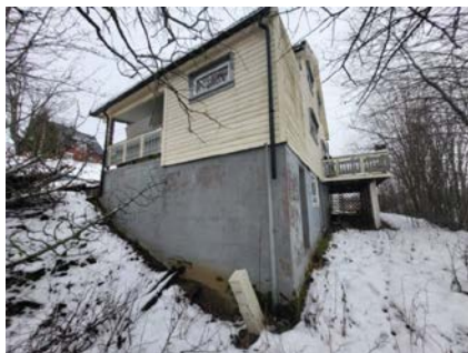
Nedløpsrør er ikke tilkoblet overvannsrør.
