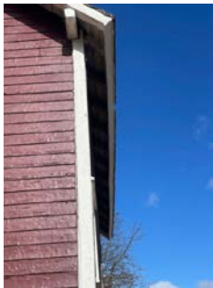
Mangler takrenne og nedløp på østsida
