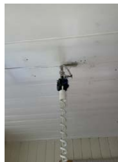
Avvik på koblingspunkt for strøm
