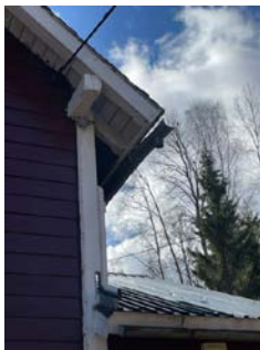
Mangler takrenne og nedløp på østsida
