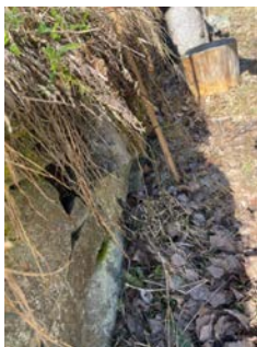
Synlige sprekker og skjevheter i mur.
