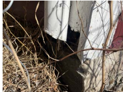
Eksempel på råteskadet trekledning.
