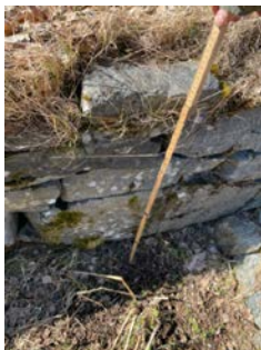
Synlige sprekker og skjevheter i mur.
