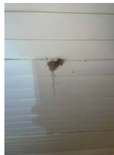
Avvik på koblingspunkt for strøm
