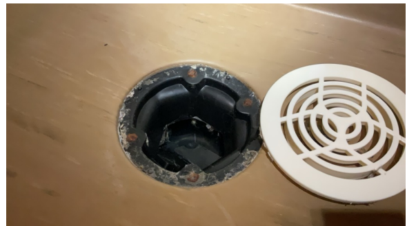
Kontroll av sluk.
