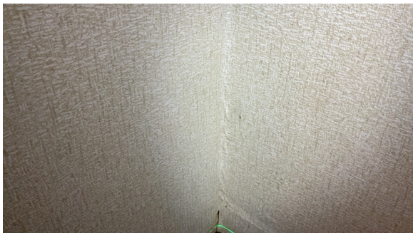
Tapet løsner i hjørner.
