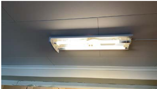
Armatur på kjøkken mangler deksel.
