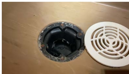
Kontroll av sluk.
