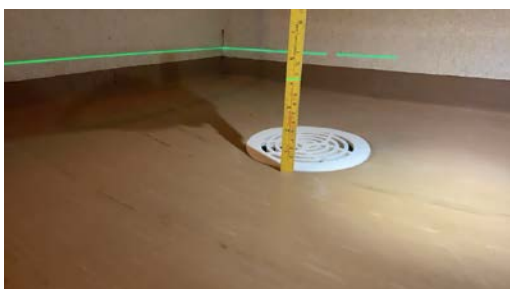
Målt fall til sluk: 55mm
