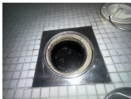
Sluk i plast, plassert i dusjnise
