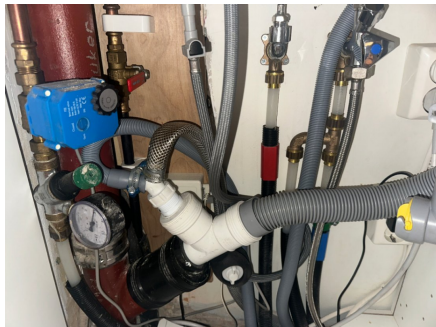
Rørpropplegg i kjøkkenbenk med Waterguard
