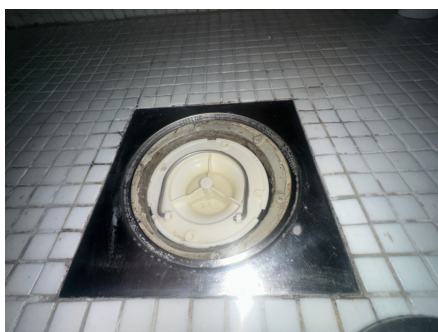
Sluk i plast, plassert i dusjnise
