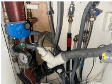
Røropplegg i kjøkkenbenk med Waterguard
