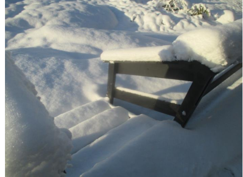
Trapp ned i fra terrasse.
