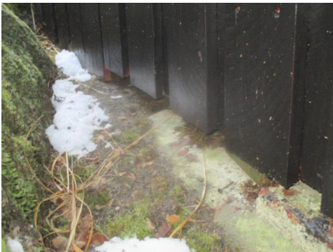
Kledning ligger nær bakkenivå.
