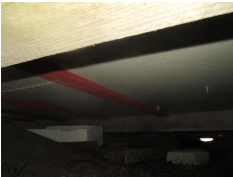
Stubbloft av plater på tilbygget del.
