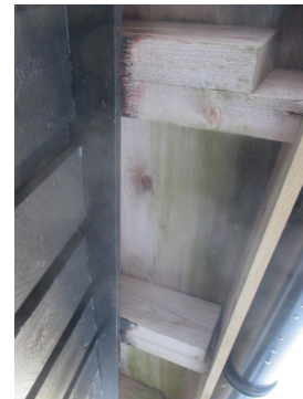
Deler av gesimsen på baksiden av hytta er ikke ferdigstilt.
