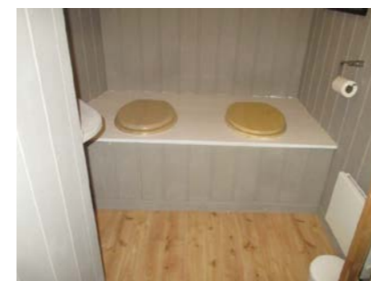
Deler av toalettrommet.
