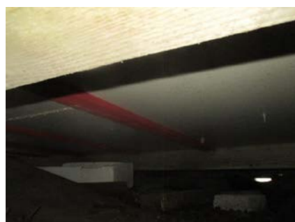
Stubbloft av plater på tilbygget del.
