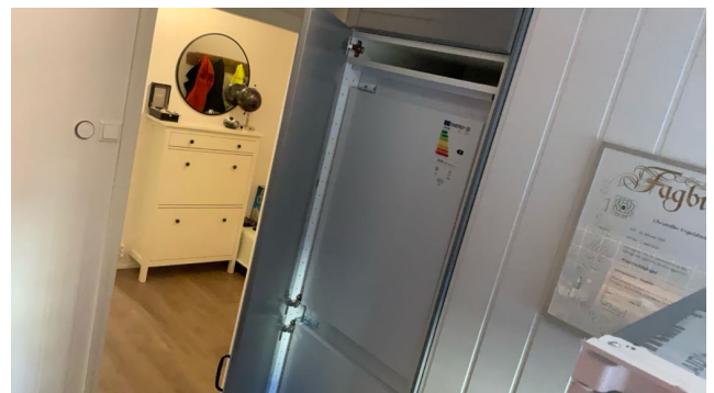
Dører er ikke montert til kjølfryseskap.
