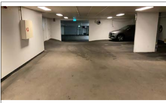
Felles garasjeanlegg i kjelleretasjen.
