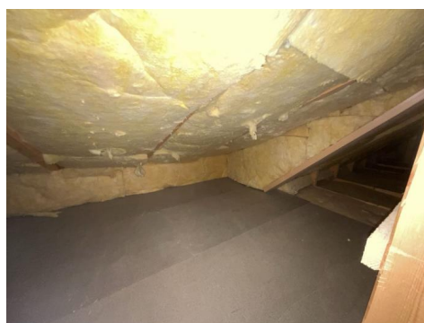
Del av takkonstruksjon, sett fra loft.
