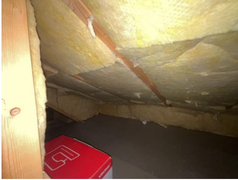
Del av takkonstruksjon, sett fra loft.
