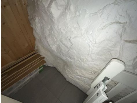
Del av rom under terreng.
