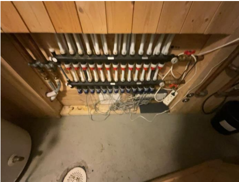
Eksempel på rør til vannbårenvarme.
