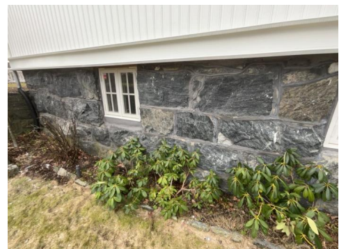
Del av grunnmur.
