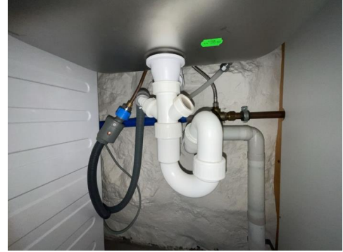
Del av rør til vann.
