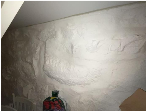
Del av rom under terreng.
