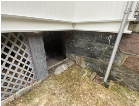
Del av grunnmur.
