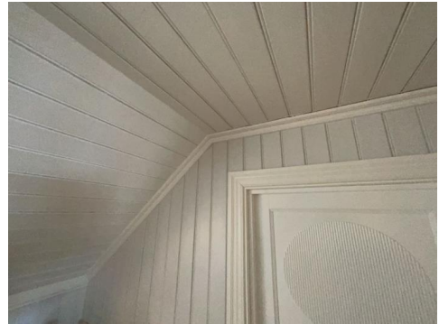
Del av vegg - tak.
