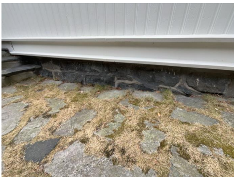
Del av grunnmur.
