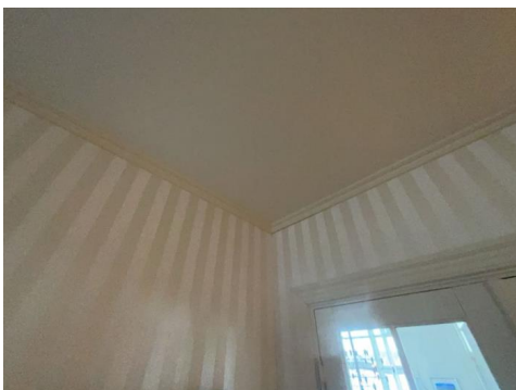
Del av vegg - tak.
