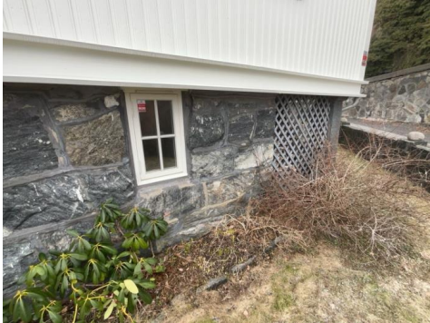
Del av grunnmur.
