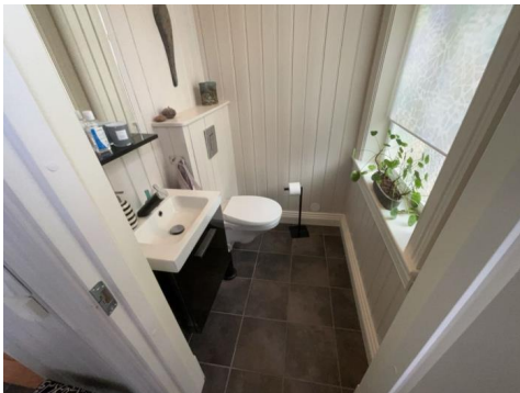
Montert håndvask. Monter wc.
