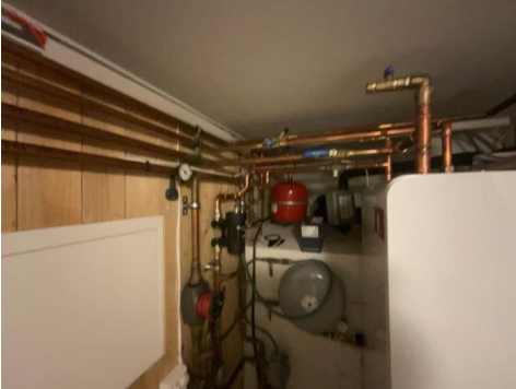
Eksempel på rør til vannbårenvarme.
