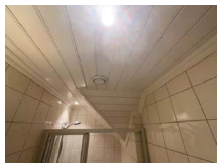
Montert avtrekk i tak. 2 ETASJE > BAD 2
