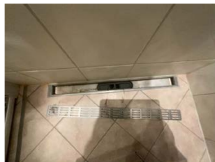
Sluk i gulv. 2 ETASJE > BAD 2
