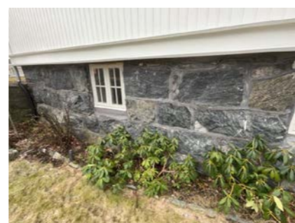
Del av grunnmur.
