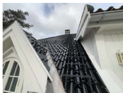
Del av taktekking.
