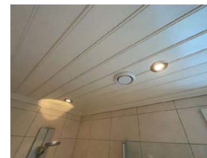
Montert avtrekk i tak. 2 ETASJE > HOVEDBAD
