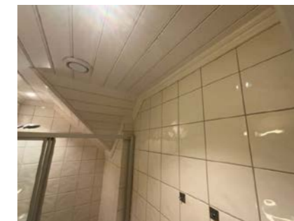
Del av vegg - tak.
