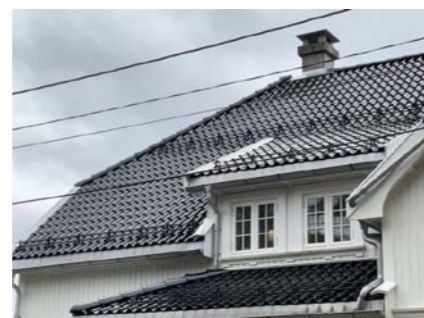
Del av taktekking.
