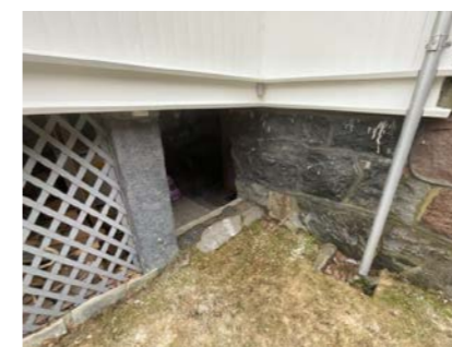
Del av grunnmur.
