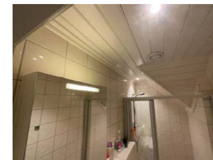
Del av vegg - tak. 2 ETASJE > BAD 2
