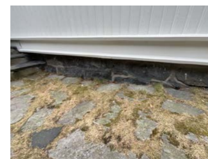
Del av grunnmur.
