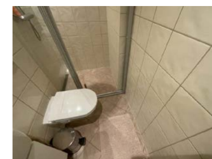
Del av gulv. 2 ETASJE > BAD 2
