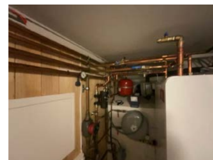
Eksempel på rør til vannbårenvarme.
