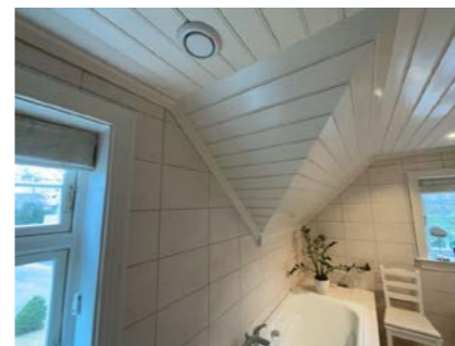
Del av vegg - tak. 2 ETASJE > HOVEDBAD
