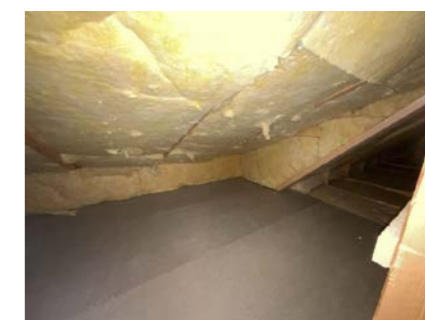
Del av takkonstruksjon, sett fra loft.
