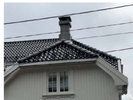
Del av taktekking.
