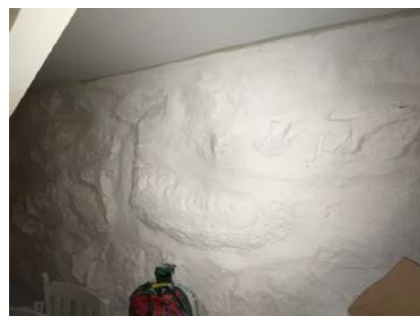
Del av rom under terreng.
