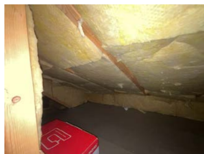
Del av takkonstruksjon, sett fra loft.
