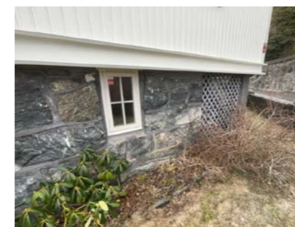
Del av grunnmur.
