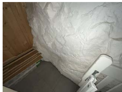
Del av rom under terreng.
