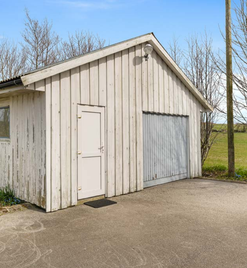
Frittstående garasje med egen arbeidsbod.
