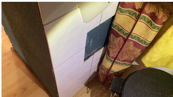
Sotluke på kjøkken.
