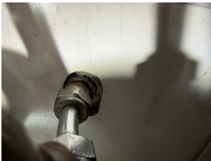
Eksempel på Utett rørgjennomføring under servant.
