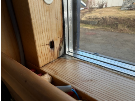
Eksempel på tegn til kondensering innvendig.
