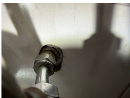
Eksempel på Utett rørgjennomføring under servant.
