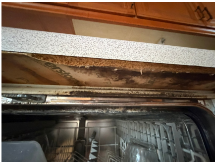
Benkeplaten ved oppvaskmaskinen har fuktskader.
