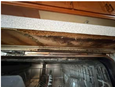
Benkeplaten ved oppvaskmaskinen har fuktskader.
