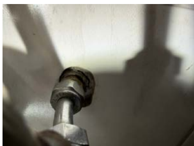
Eksempel på Utett rørgjennomføring under servant.
