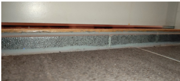
Kontroll av høyde på luftespalte under døren.
