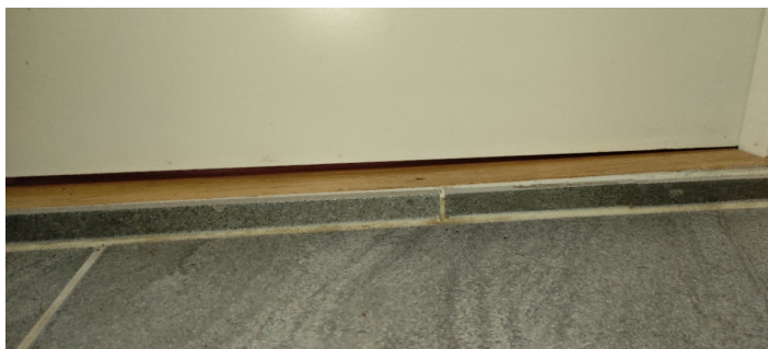
Kontroll av høyde på luftespalte under døren.
