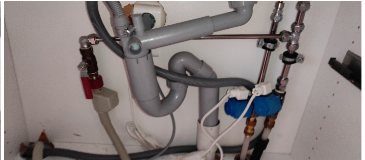
Kontroll av røropplegg.
