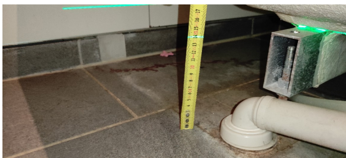
Kontroll av fall mot sluk.
