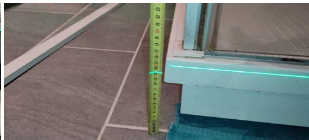
Kontroll av fall mot sluk.
