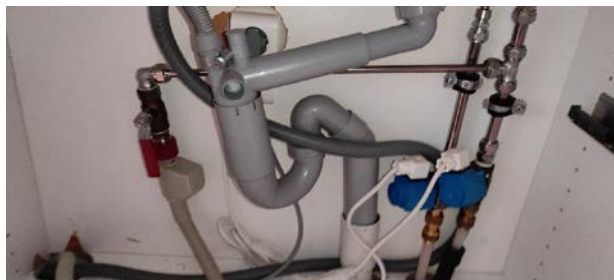
Kontroll av røropplegg.
