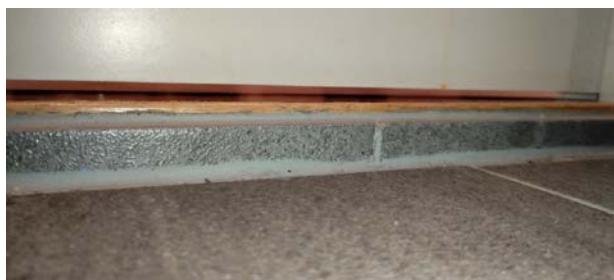
Kontroll av høyde på luftespalte under døren.
