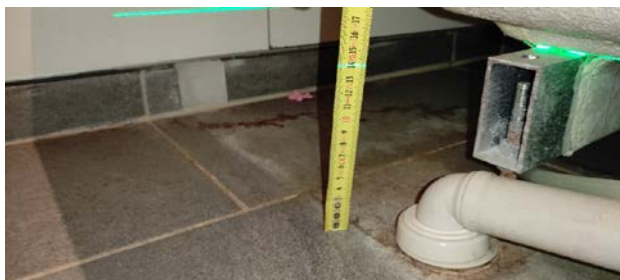
Kontroll av fall mot sluk.
