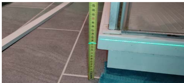
Kontroll av fall mot sluk.
