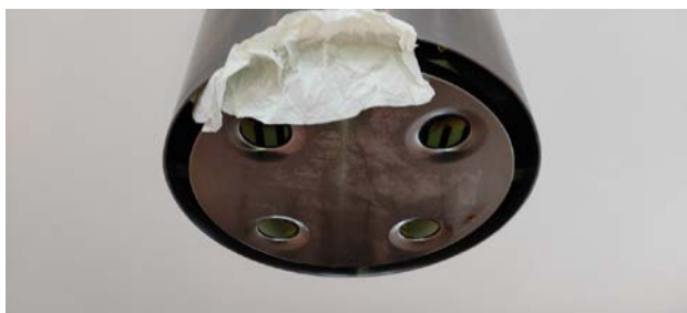
Funksjonstest av ventilator.
