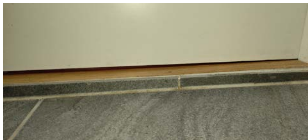
Kontroll av høyde på luftespalte under døren.
