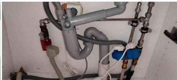
Kontroll av røropplegg.
