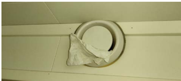
Funksjonstest av avtrekk.
