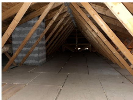
Oversiktsbilde fra loft.
