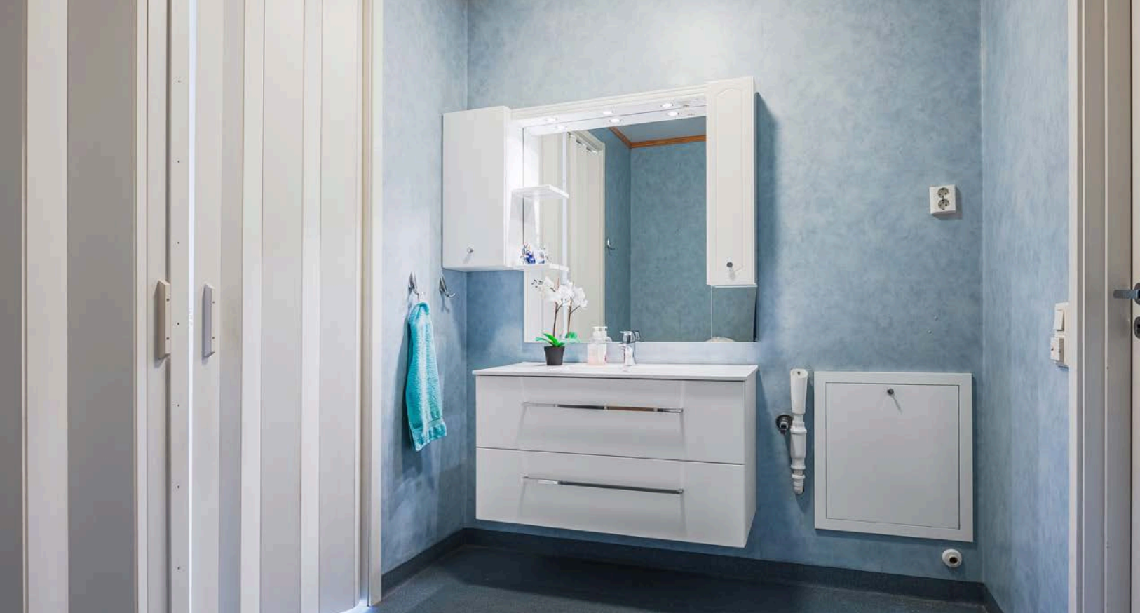
Baderom fra byggeåret 2000 med belegg på gulv, elektrisk gulvvarme og våtromstapet på veggene.
