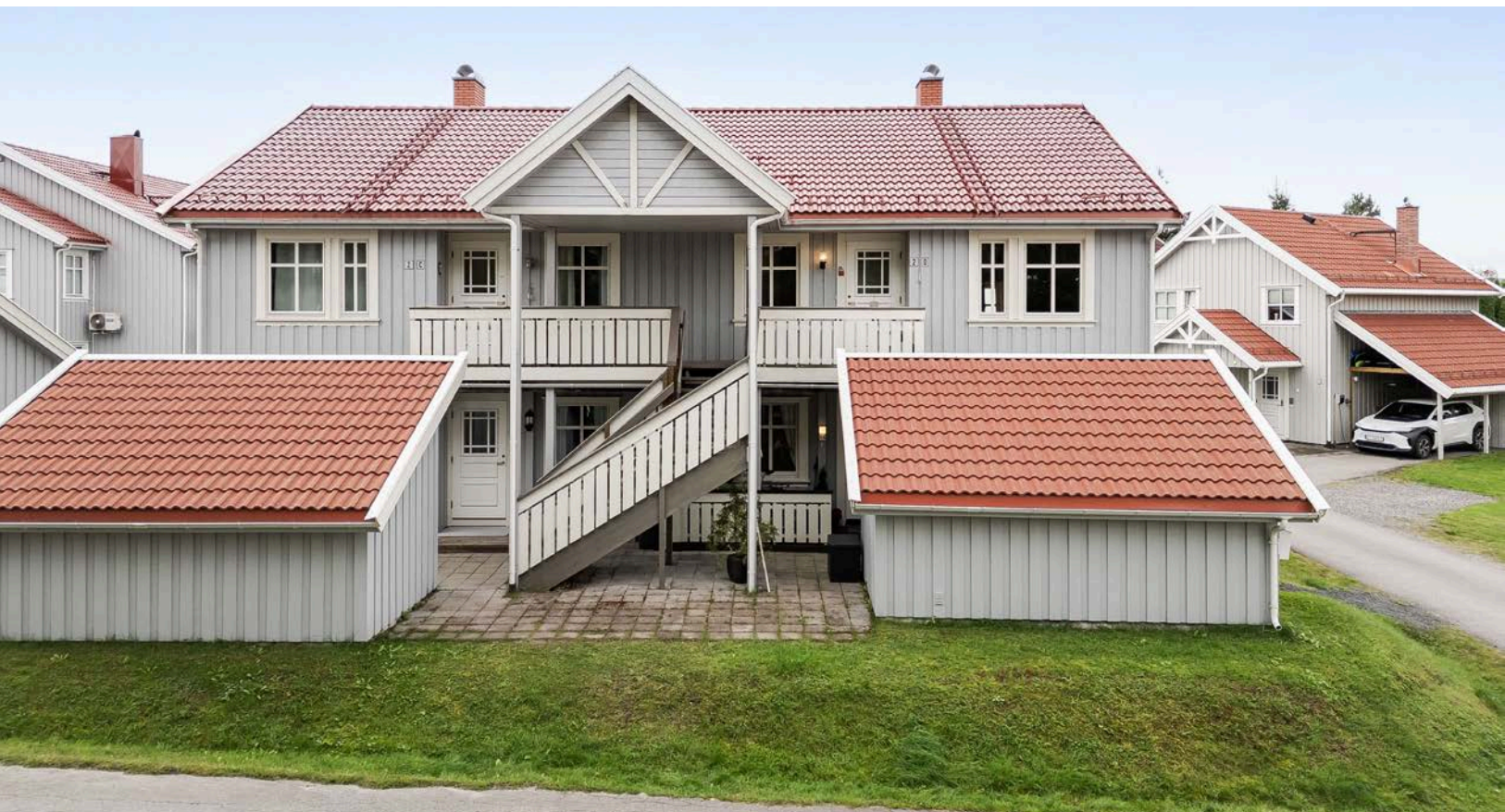
Det ble utført takvask og takfornyning i 2025. Taket er behandlet med 2 strøk Gjøco taksteinsolje farge teglrød. Kledningen er sist overflatebehandlet i ca. 2021 og takrenner ble skiftet ut i 2017.
