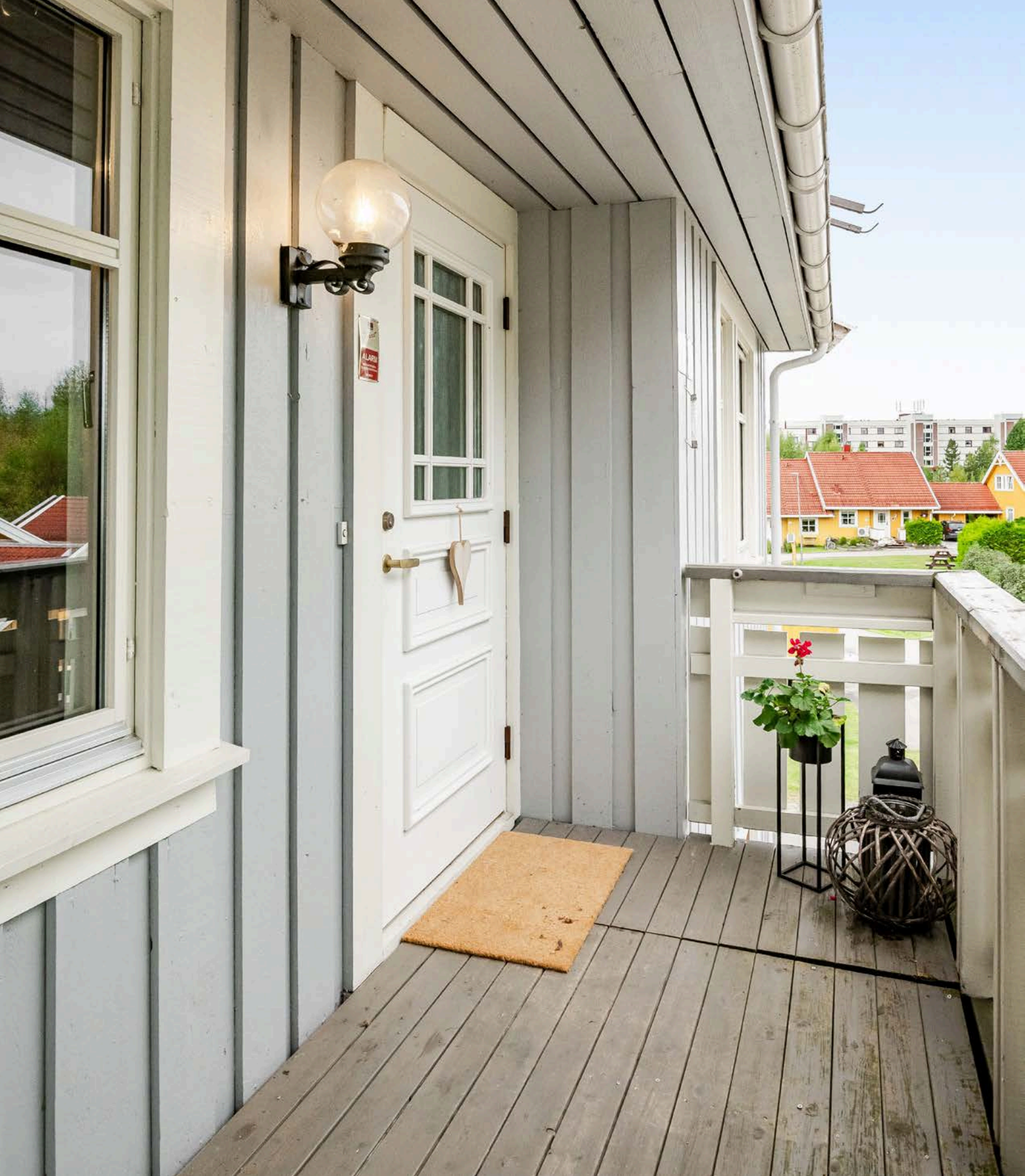
Inngangspartiet har beiset terrassebord på gulv og malt rekkverk. Det er montert utebelysning og ringklokke ved inngangsdøren.
