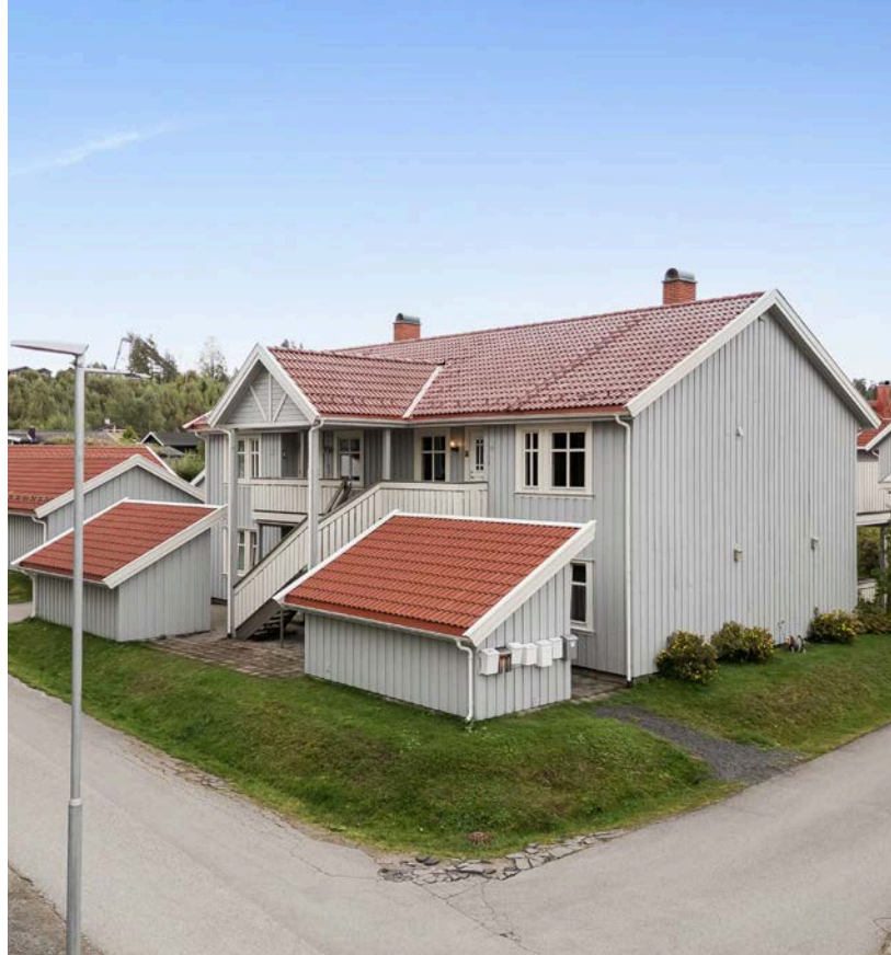
Felles eiertomt for sameiet på ca. 1 860,1m 2 . Tomten er opparbeidet med gressplen og variert beplantning.
