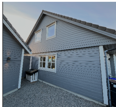
Vinduer i 1 etasje fra byggår, vinduer på loft fra 2025
