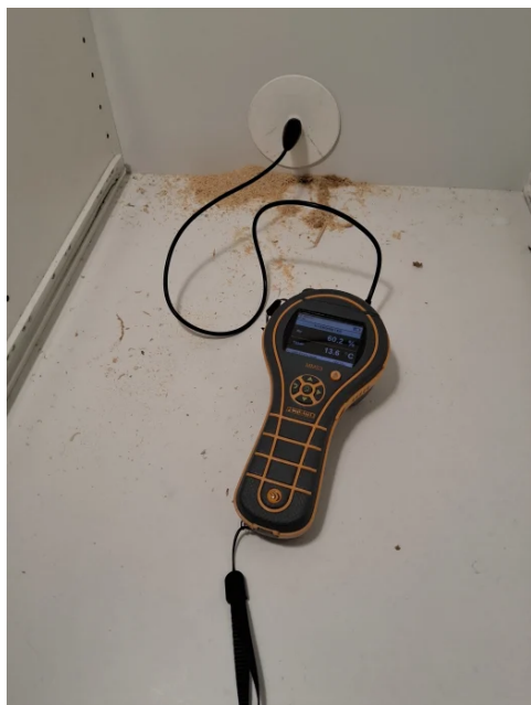
Bilde fra fuktmåling i veggkonstruksjon tilstøtende våtsone.
