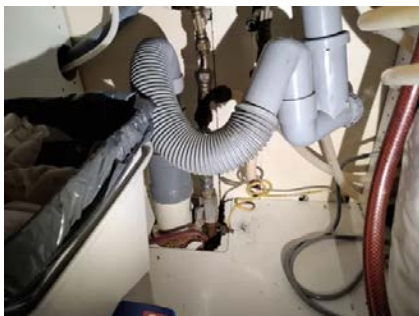
Leiligheten har synlige avløpsrør i plast og støpejern.
