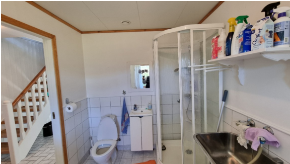
Veggene har fliser på nedre del og malt strie på øvre del.
