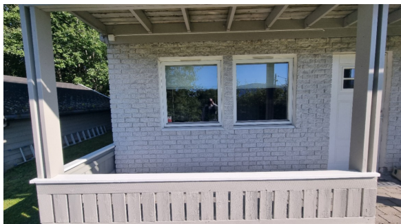
Grunnmur er utvendig tekket med fasadetegl.
