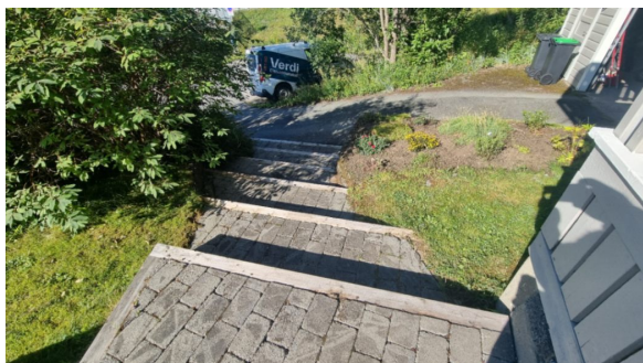
Trapp i terrenget utført med belegningsstein.
