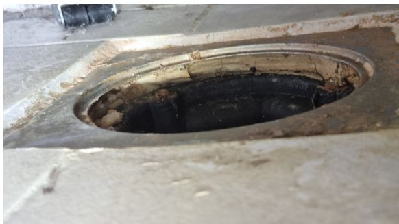
Kontroll av sluk.
