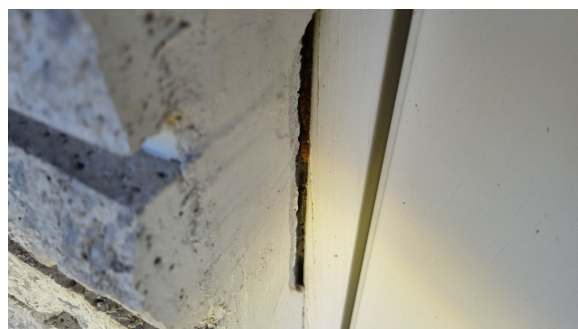
Det er stedvis utettheter rundt dørkarm.
