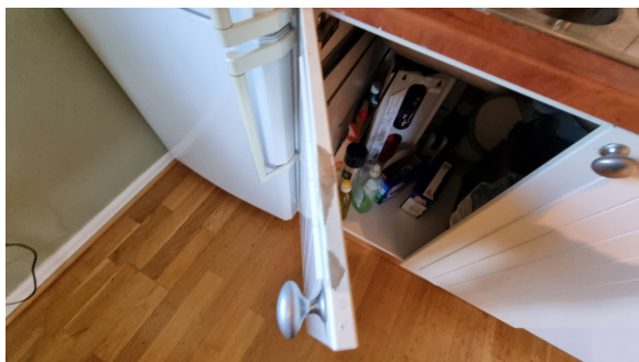
Skade i skapdør.
