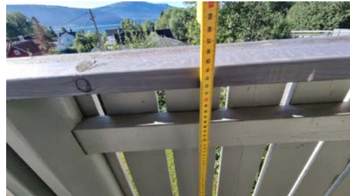
Rekkverket er for lavt i forhold til dagens krav til rekkverkshøyder.
