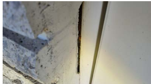
Det er stedvis utettheter rundt dørkarm.
