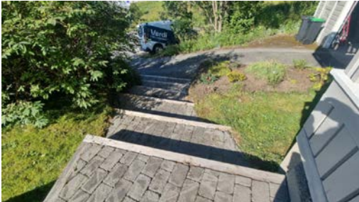
Trapp i terrenget utført med belegningsstein.
