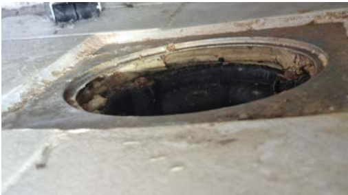
Kontroll av sluk.
