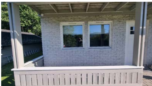
Grunnmur er utvendig tekket med fasadetegl.
