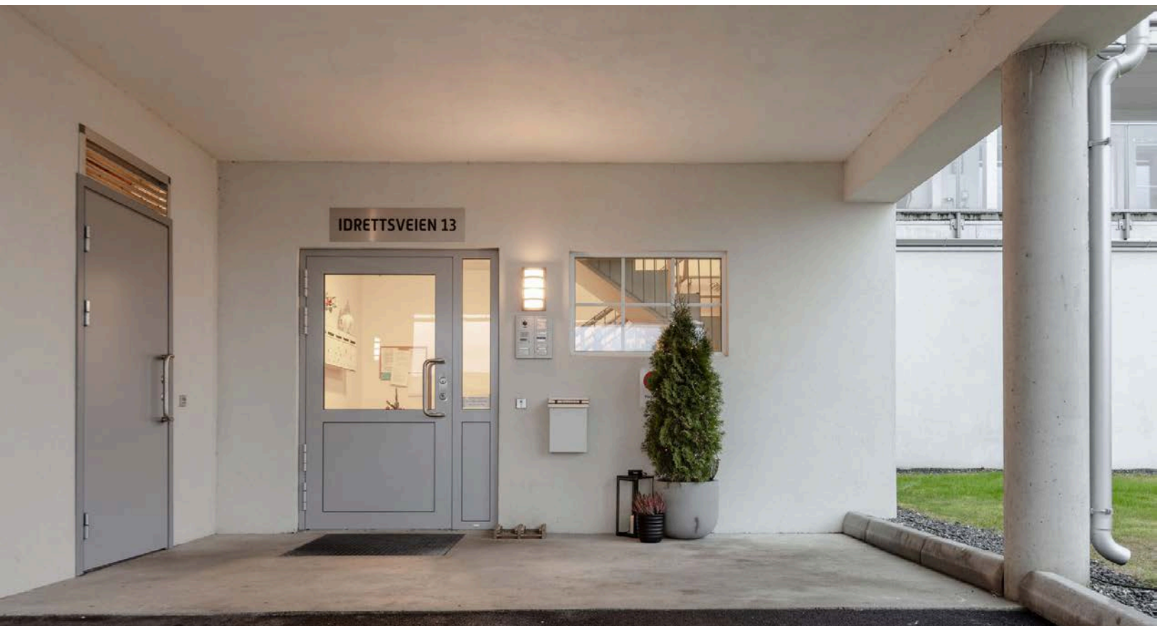
Inngangspartiet er overbygget og ryddig. Det er dørcallinganlegg til leilighetene.
