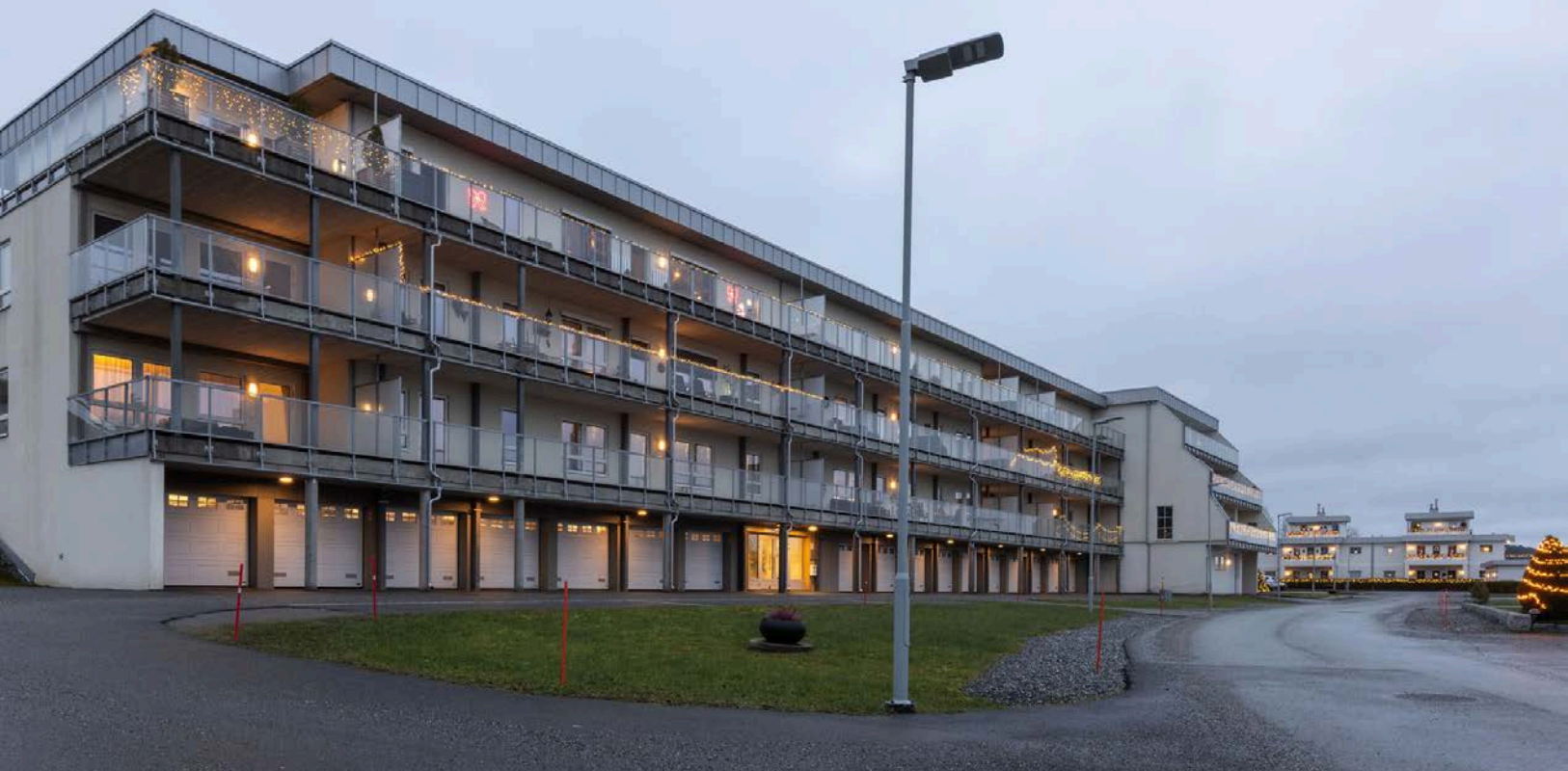
Garasjeanlegget ligger i boligblokkens 1. etasje med adkomst fra bakkeplan via motoriserte portåpnere. Leilighetene har egen garasjeport tilknyttet sin biloppstillingsplass.
