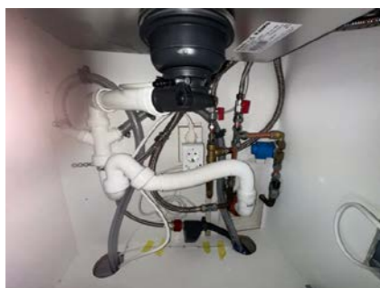
Røropplegg i kjøkkenbenk med Waterguard
