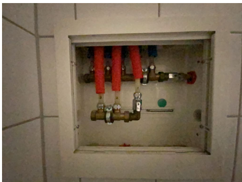
Besiktigelse av røropplegg.
