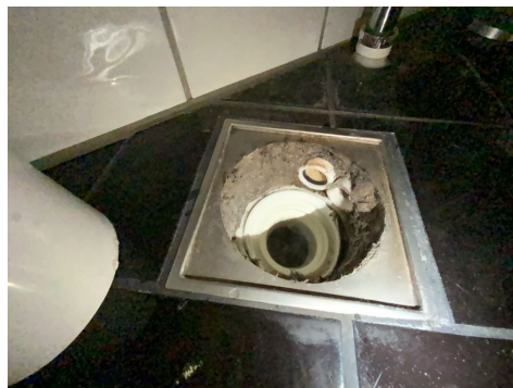
Kontroll av sluk.
